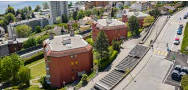
Neuchâtel, 24 bis 28, rue des Berthoudes
