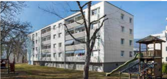
Boudry, 33/35, rte de la Gare
