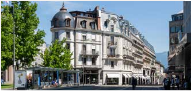
Vevey, 8 à 14, rue de Lausanne
