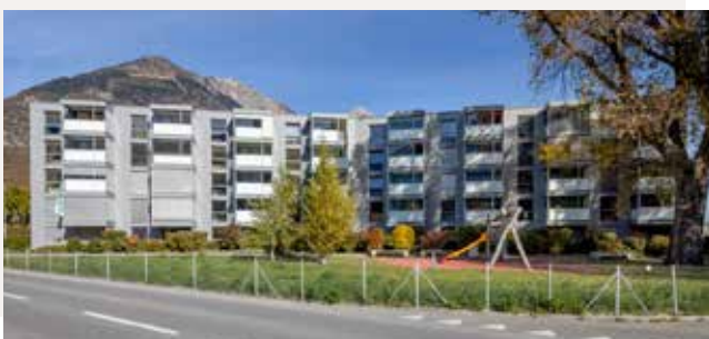
Martigny, 2 à 8, rue des Peupliers
