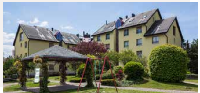
Yverdon-les-Bains, 21 à 31, rue d'Orbe
