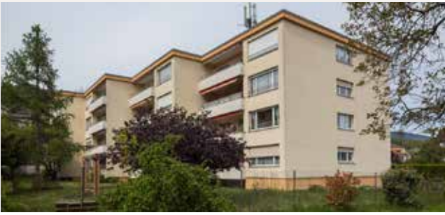
Peseux, 10/12, rue de la Gare
