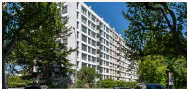
Onex, 103 et 91 à 95, av. Bois-de-la-Chapelle
