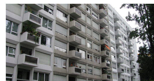
Onex , 103, av. du Bois-de-la-Chapelle
