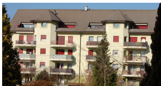
Bex , 47a à 47d, av. de la Gare
