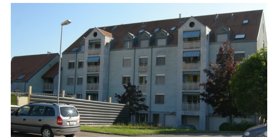
Yverdon-les-Bains , 10/12, rue de Plaisance
