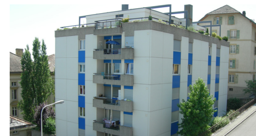
Neuchâtel , 50, rue de Fontaine-André
