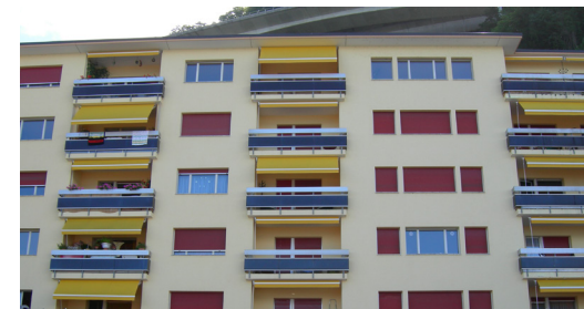
Veytaux , 6/8, rue de la Gare
