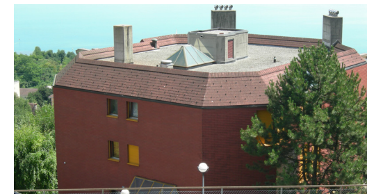
Neuchâtel , 24 à 28, rue des Berthoudes
