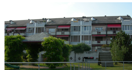
Yverdon-les-Bains , 21 à 31, rue d'Orbe
