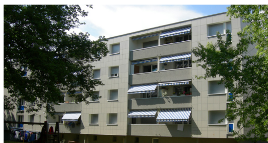
Boudry , 33/35, rte de la Gare
