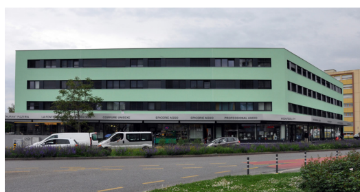
Carouge , 33 à 37, rte de Veyrier - 5/7, rte de la Fontenette
