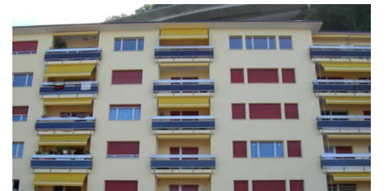
Veytaux , 6/8, rue de la Gare
