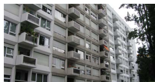
Onex , 103, av. du Bois-de-la-Chapelle
