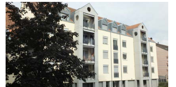
Yverdon-les-Bains , 10/12, rue de Plaisance
