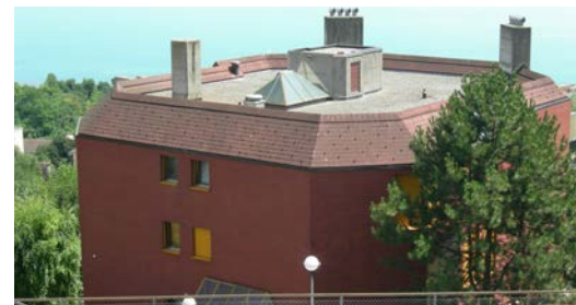
Neuchâtel , 24 à 28, rue des Berthoudes
