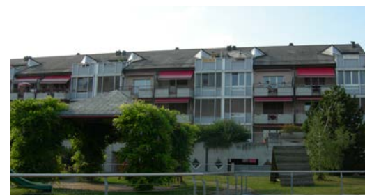
Yverdon-les-Bains , 21 à 31, rue d'Orbe
