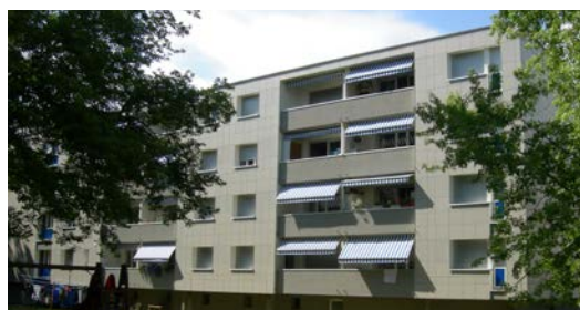
Boudry , 33/35, rte de la Gare
