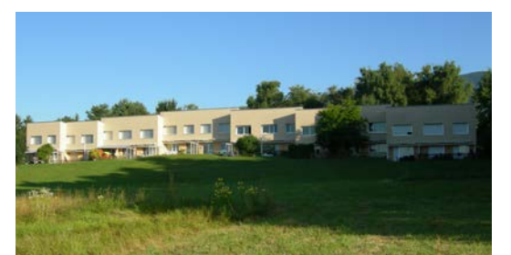
Onnens , 1 à 12, rte de la Gare
