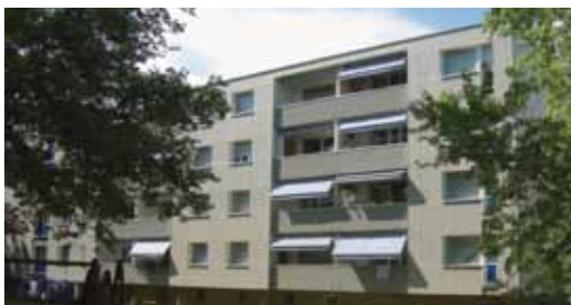
Boudry , 33/35, rte de la Gare
