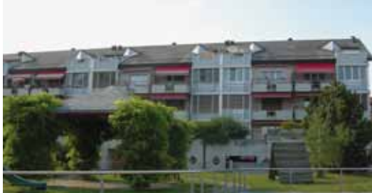
Yverdon-les-Bains , 21 à 31, rue d'Orbe
