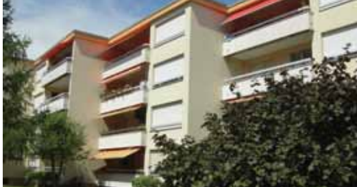
Peseux , 10/12, rue de la Gare
