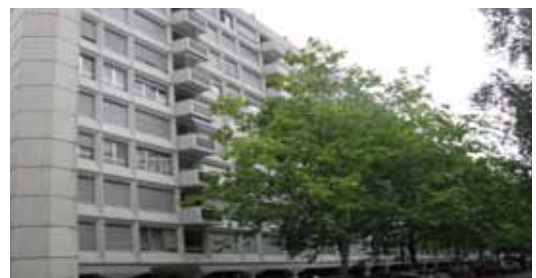
Onex , 91 à 95, av. du Bois-de-la-Chapelle
