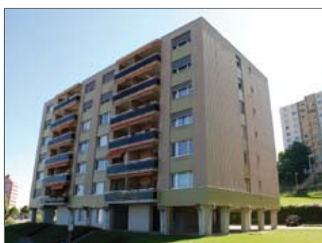
CHAUX-DE-FONDS 34E+F, RUE FRITZ-COURVOISIER
