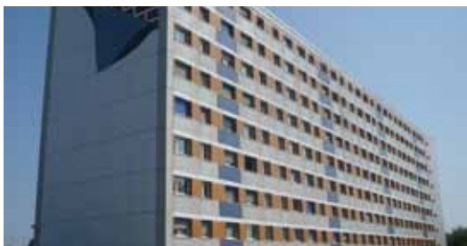
Nyon , - Ch. du Reposoir 1-3-5-7
