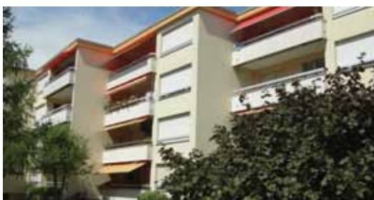
Peseux , Rue de la Gare 10-12
