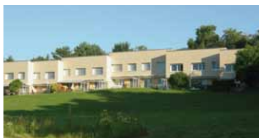
Onnens , Rte de la Gare 1 à 12
