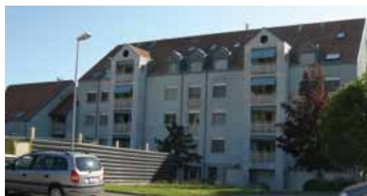
Yverdon , Rue de Plaisance 10-12
