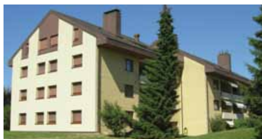
Bussigny , Rue Cocagne 10-12 / Rue Rietaz 17-19
