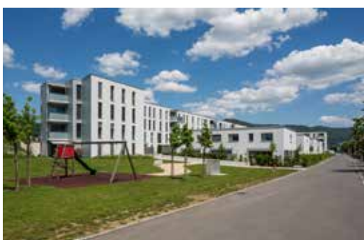
Delémont , 2, rue du Voirnet - 3/9/15/17, rue Emile-Boéchat
