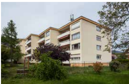
Peseux , 10/12, rue de la Gare
