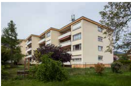
Peseux , 10/12, rue de la Gare
