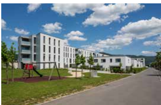
Delémont , 2, rue du Voirnet - 3/9/15/17, rue Emile-Boéchat
