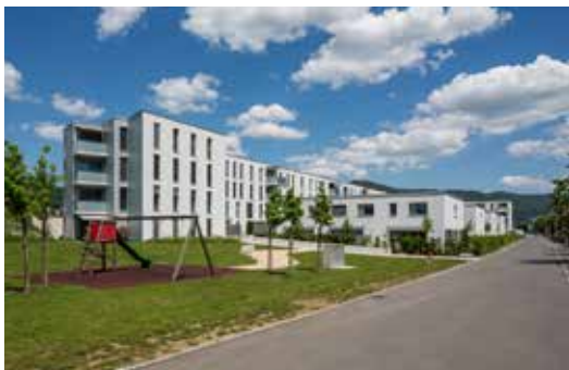
Delémont , 2, rue du Voirnet - 3/9/15/17, rue Emile-Boéchat
