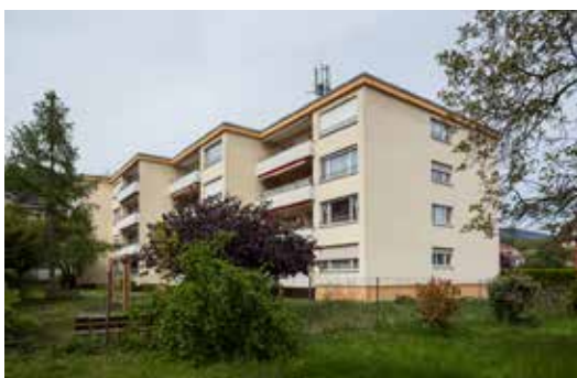
Peseux , 10/12, rue de la Gare
