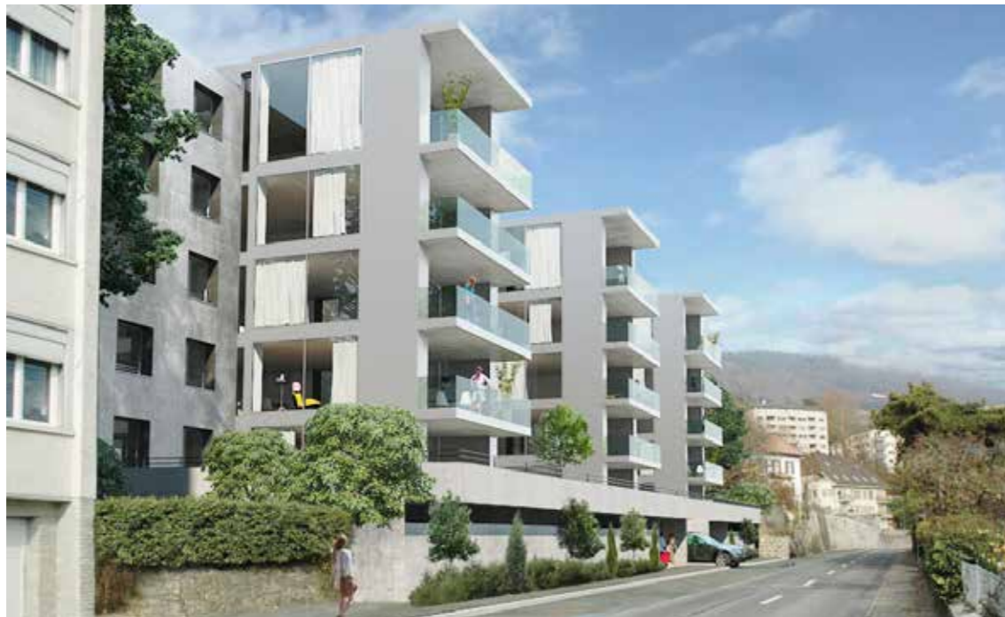
119, rue des Saars, Neuchâtel - Zusammenfassendes Foto
